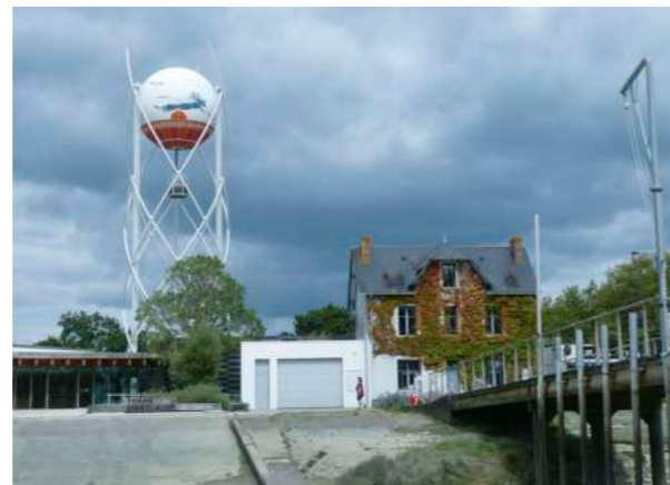
Het huis van de havenmeester en de uitkijktoren bij het bezoekerscentrum van de Loire-Atlantique.
